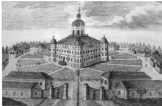
Residenzschloss Karlsruhe in Schlesien
