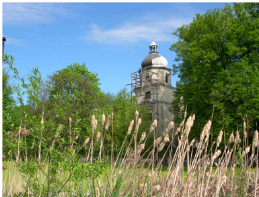
Ruine des Herrenhauses (2007) Aufnahme: Tomasz Mietlicki
